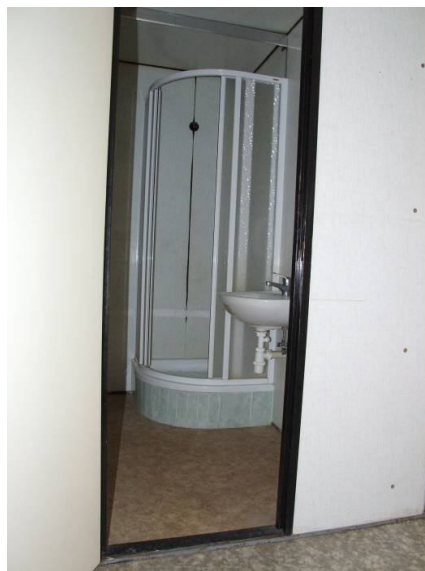
vana odstraněna a nahrazena sprchovým koutem se zástěnou
