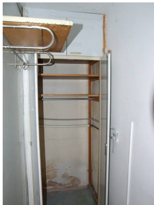
vestavěná šatní skříň a police – zadní stěna poškozena vlhkostí
