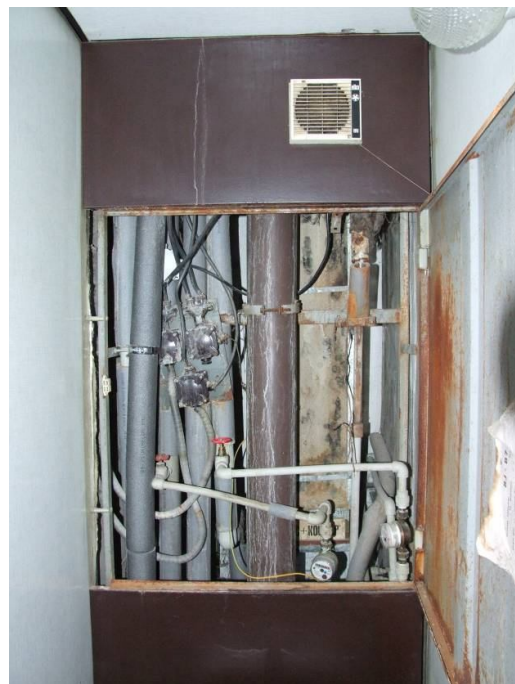
revizní otvor do instalační šachty + odtahový ventilátor
