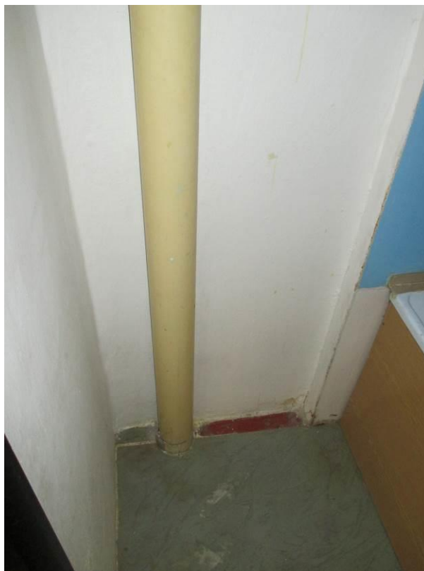
Dešťové odpadní potrubí v koupelně.
