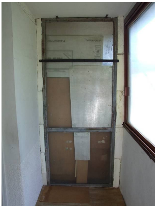
dělicí lodžiová stěna z ocelovou konstrukcí a výplní z drátoskla
