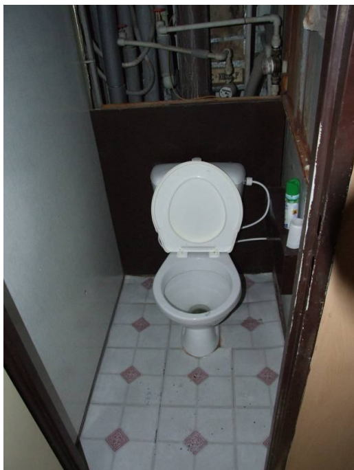
toaletní mísa v provedení kombi, podlaha z PVC a plechová zadní stěna mezi WC a instalační šachtou
