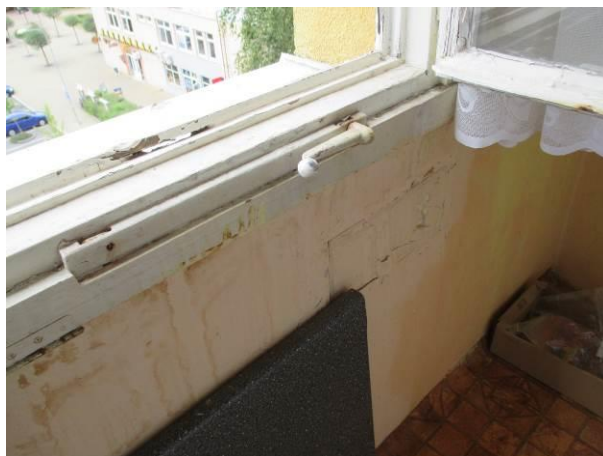
Detail odžilého rámu okna a vlhkostní projevy na stěně pod oknem.
