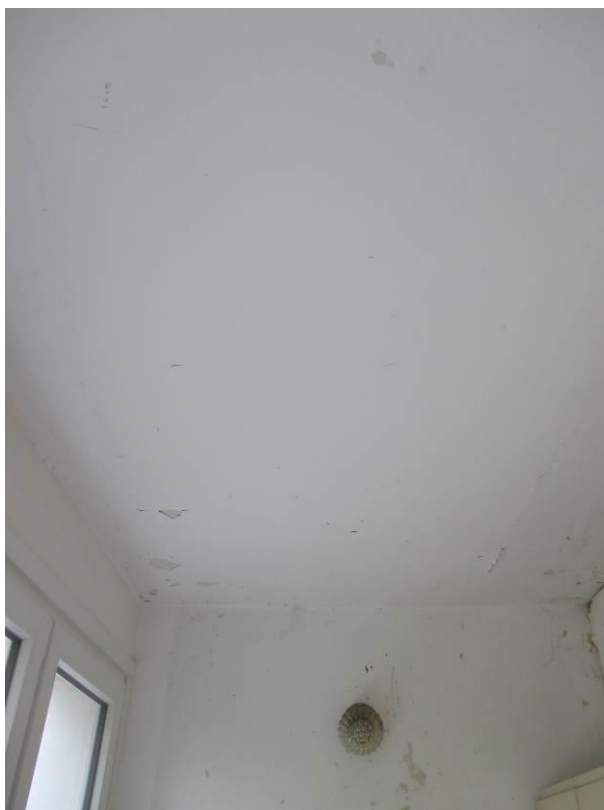
Pohled na strop nad kuchyňským koutem, viditelné poškození vlhkostí.
