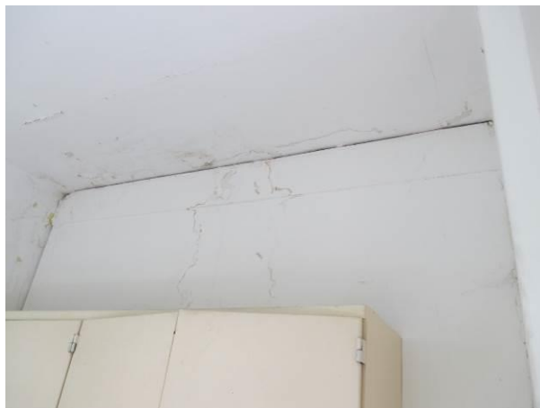
Prostor nad kuchyňskou linkou, stěna i strop poškozeny vlhkostí.
