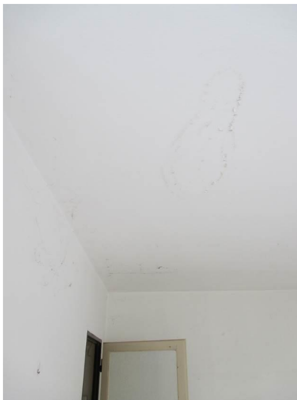
Pohled na strop nad obytným prostorem, viditelné poškození vlhkostí.
