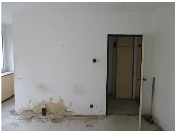
Pohled z obytného prostoru na dělicí příčku, vlevo dole značné poškození vlhkostí.
