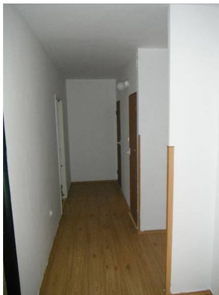
rohové ochranné svíslé profily na konstrukcích příčky
