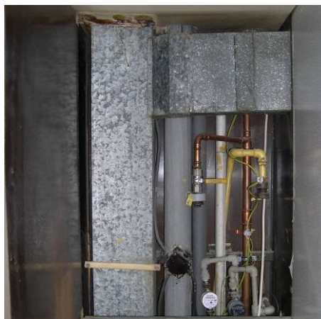
rozvody v instalační šachtě (za záchodovou mísou)
