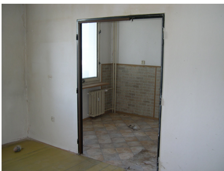
ocelová zárubeň pro dvoukřídlové dveře z obývacího pokoje do kuchyně
