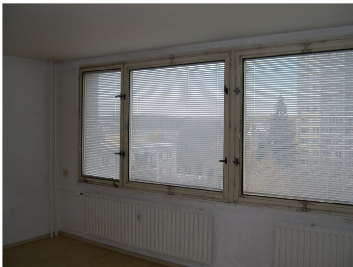
okenní výplň v obývacím pokoji – okenní sestava dvou dvoukřídlových oken
