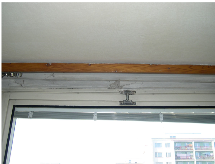
mechanické poruchy v napraží okna v obývacím pokoji
