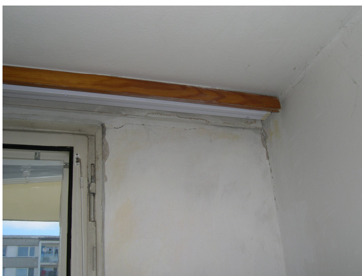
trhliny v nadpraží okna a na styku obvodového pláště a zděné přičky – ložnice m.č. 07
