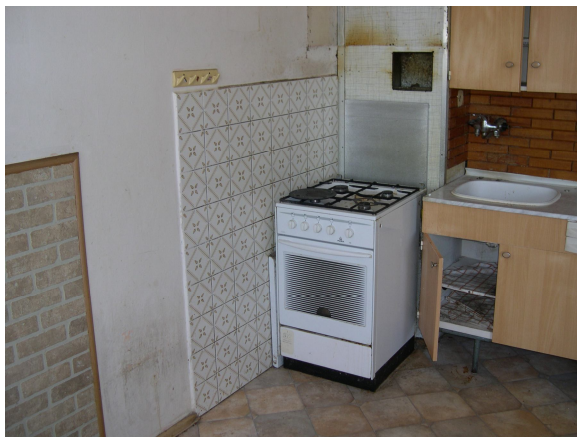
kuchyňská linka s kombinovaným sporákem + otvor pro napojení digestoře na VZT odtahové potrubí v instalační šachtě
