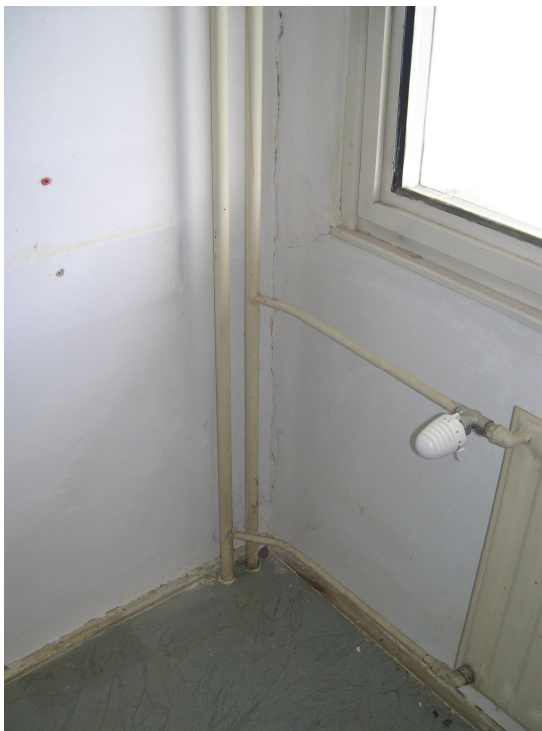
trhlina na styku obvodového pláště a příčné stěnové konstrukce – ložnice m.č. 07
