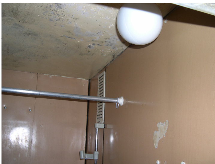
odvětrání prostoru koupelny + konstrukce podhledu s výskytem plísně
