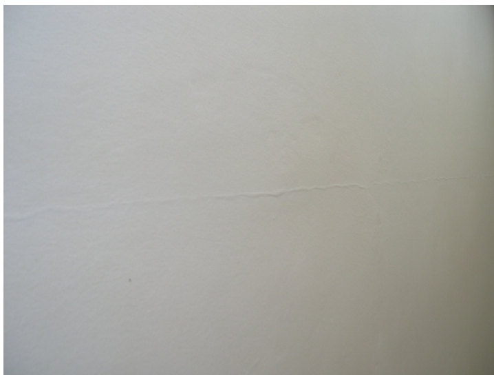
spára mezi stropními panely – obývací pokoj
