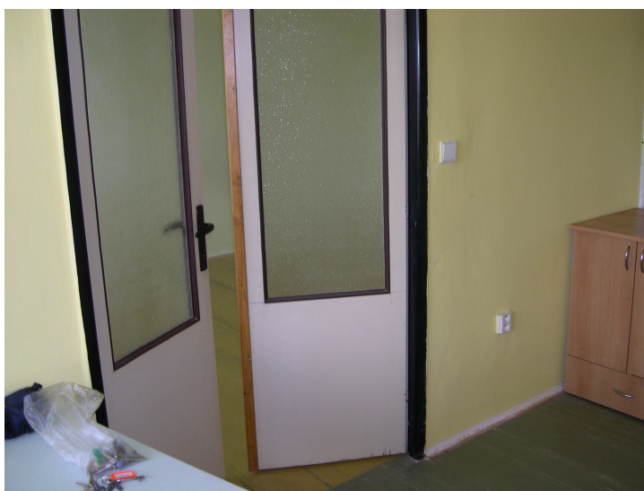
dvoukřídlové dveře z kuchyně do obývacího pokoje osazené v ocelové zárubni
