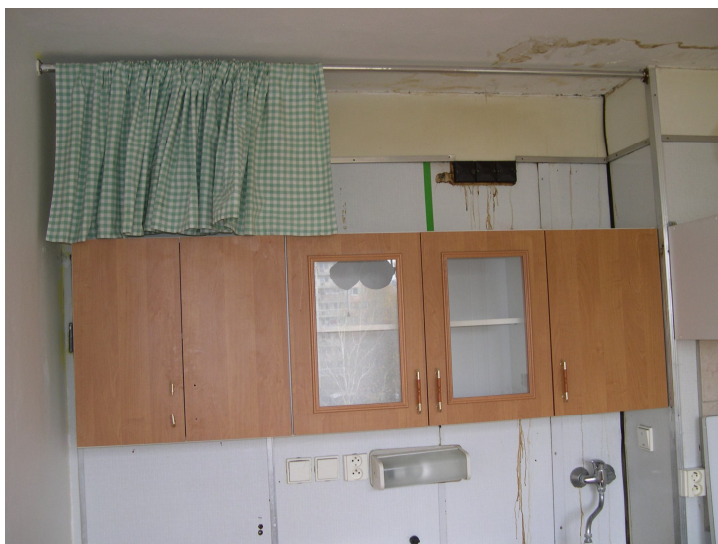
stopy po zatékání ze sociálního zařízení v bytě nad tímto bytem – v kuchyni v místě instalační šachty
