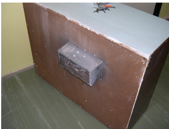
spízní skříň včetně zařízení pro odvětrání
