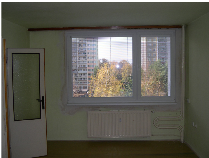
okno v obývacím pokoji + vyrovnávací kus na stoupačkách UT
