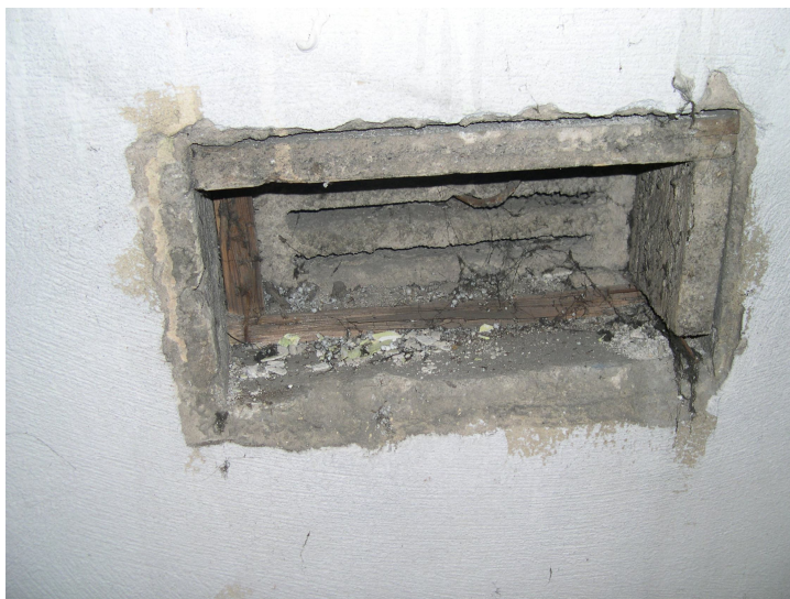
odvětrání spízní skříně
