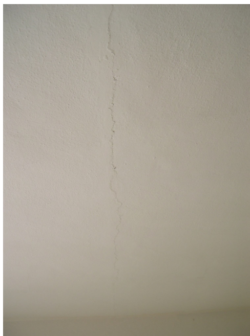
trhliny na styku stěnových panelů – v obývacím pokoji
