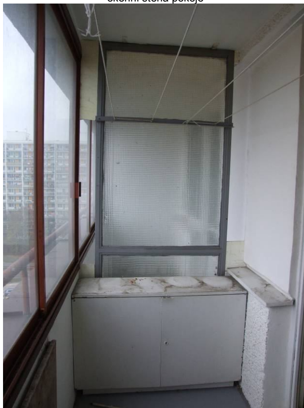
skříňky a lodžii a dělicí oceloprosklená stěna
