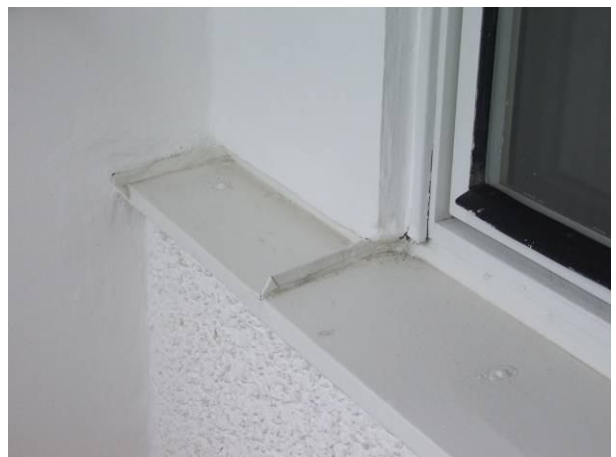
osazení okna v drážce, pohled z exteriéru
