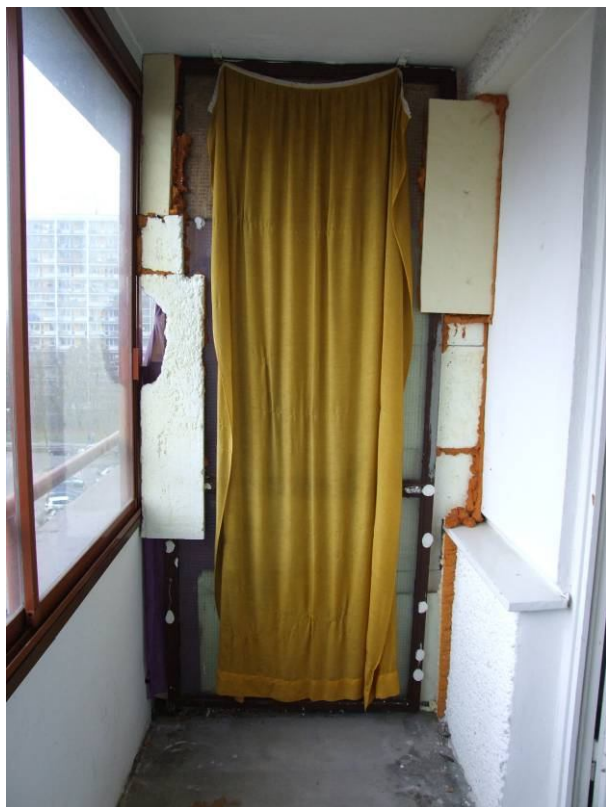
dělicí stěna s neodbornými úpravami
