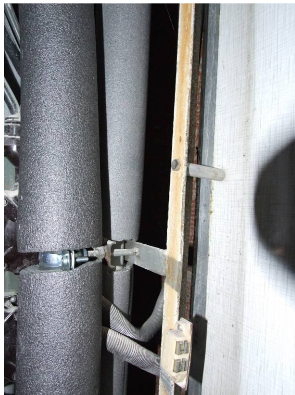
kotvení instalací v šachtě
