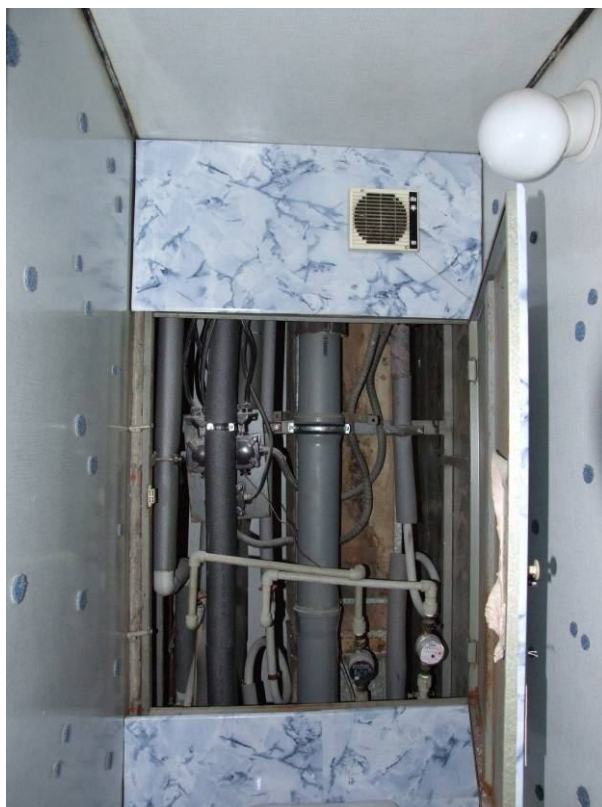
instalační šachta a ventilátor WC
