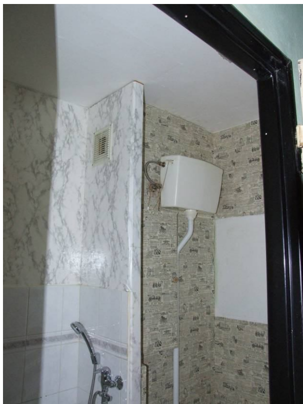
horní nádržka, prostor opatřen voděodolnou tapetou
