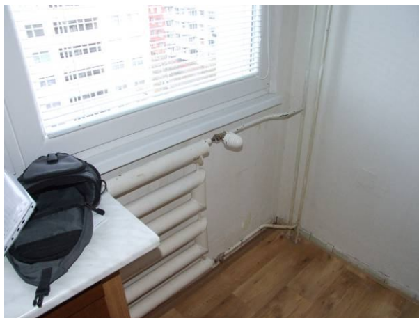
trubkový konvektor ústředního topení
