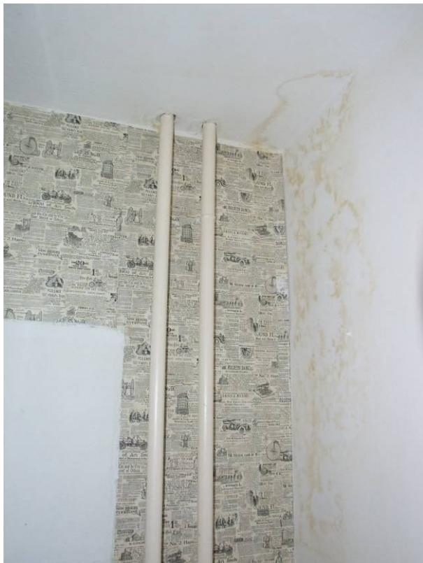
stopy po zatečení na stěna a stropu WC
