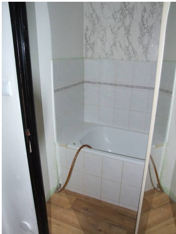
vyměněná vanička s obloženým čelním zákrytem
