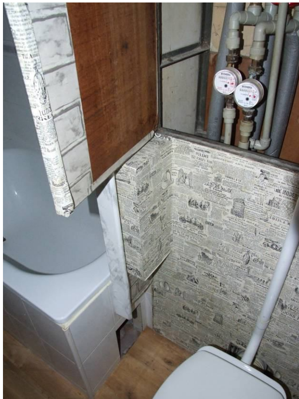
pohled do instalační šachty a zákryt vodovodního potrubí
