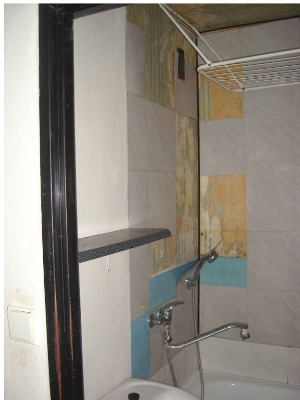
Koupelna – rozhraní zděné příčky a konstrukce z umakartových desek.
