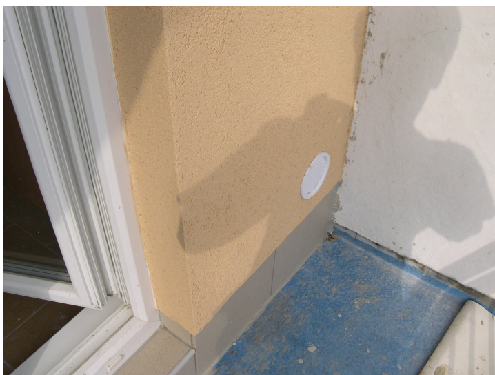
odvětrání spížní skříně – ze strany exteriéru
