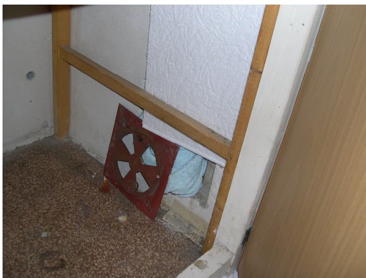
odvětrání spíží skříně ze strany spíží skříně u podlahy
