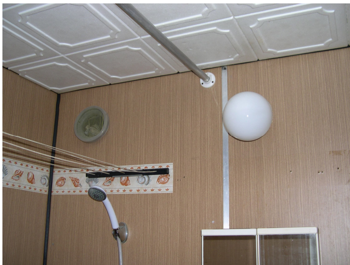
odvětrání koupelny + kazetový podhled z polystyrénu + vybavení koupelny
