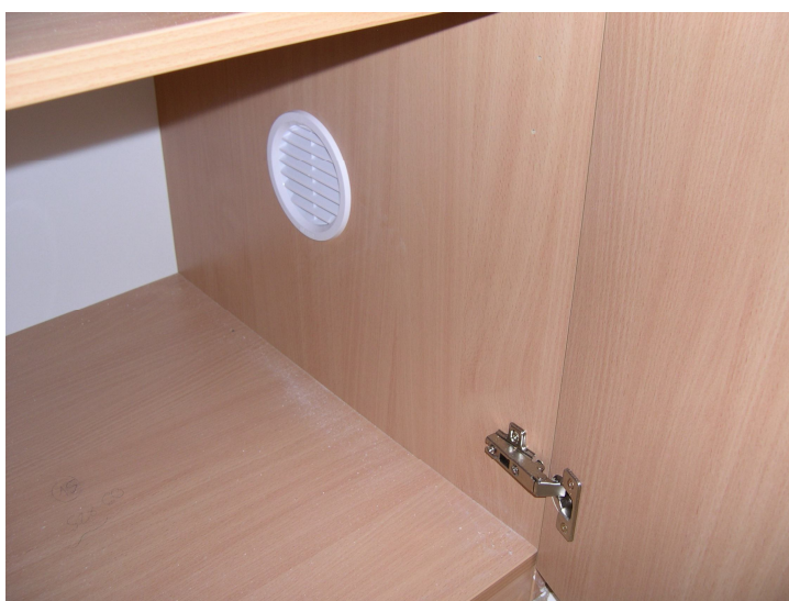
odvětrání spížní skříně ze strany spížní skříně
