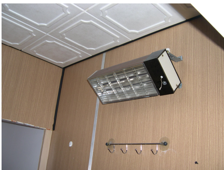
infrazářič v koupelně + kazetový polystyrénový podhled
